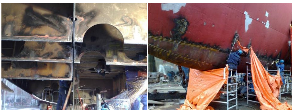
Binnenwerk en Bodemplaten vervangen
