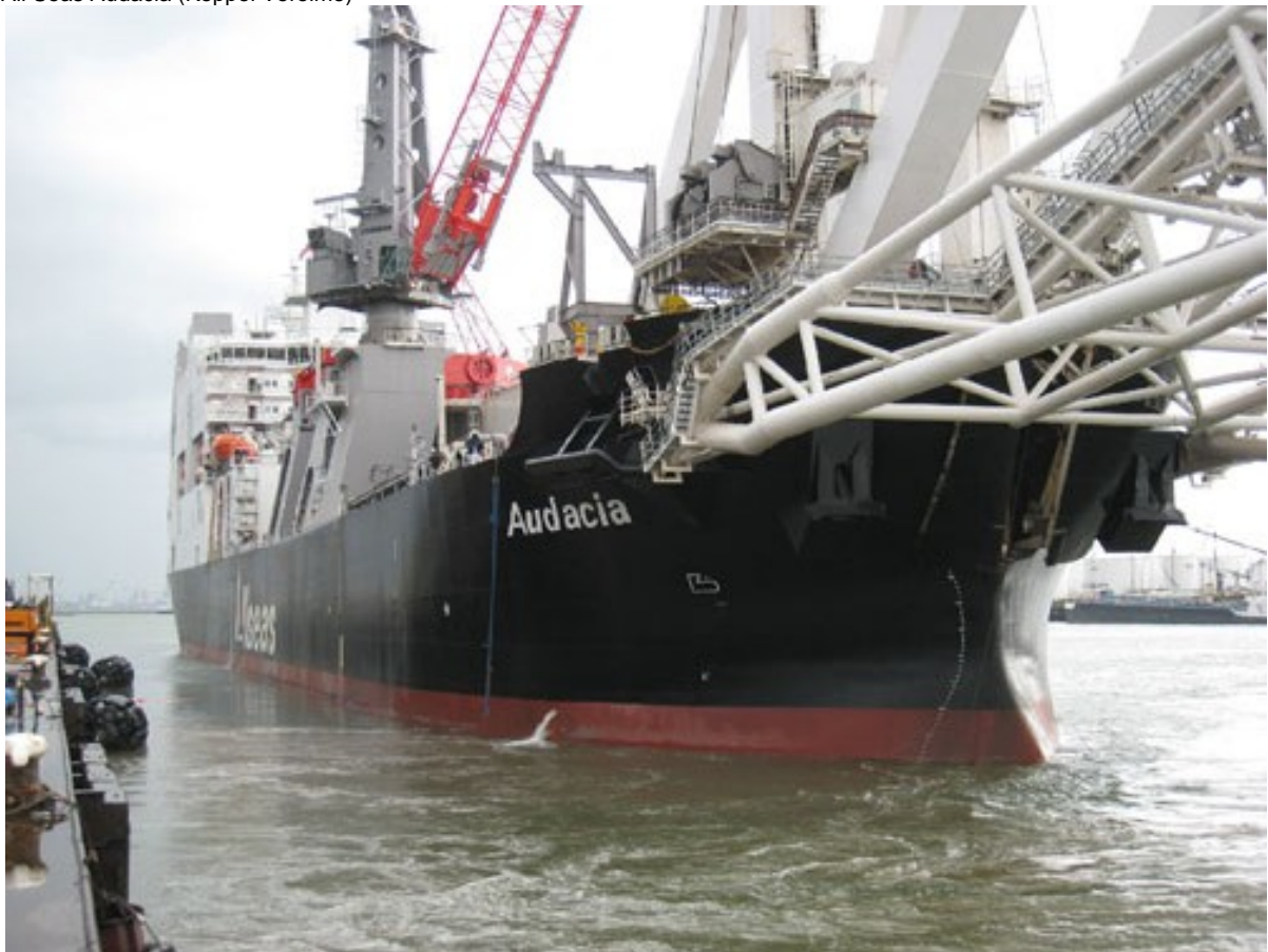
(Cable trunks plaatsen, ruimen dichtgemaakt met deckbeplating, superstructure en crane tube geplaatst en diverse punchitems)
